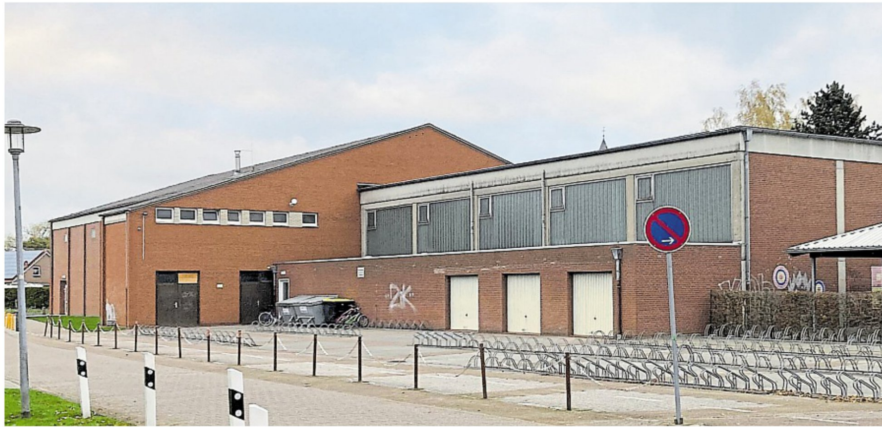
Die in die Jahre gekommenen Turnhallen an den Michaelschulen werden abgerissen.
