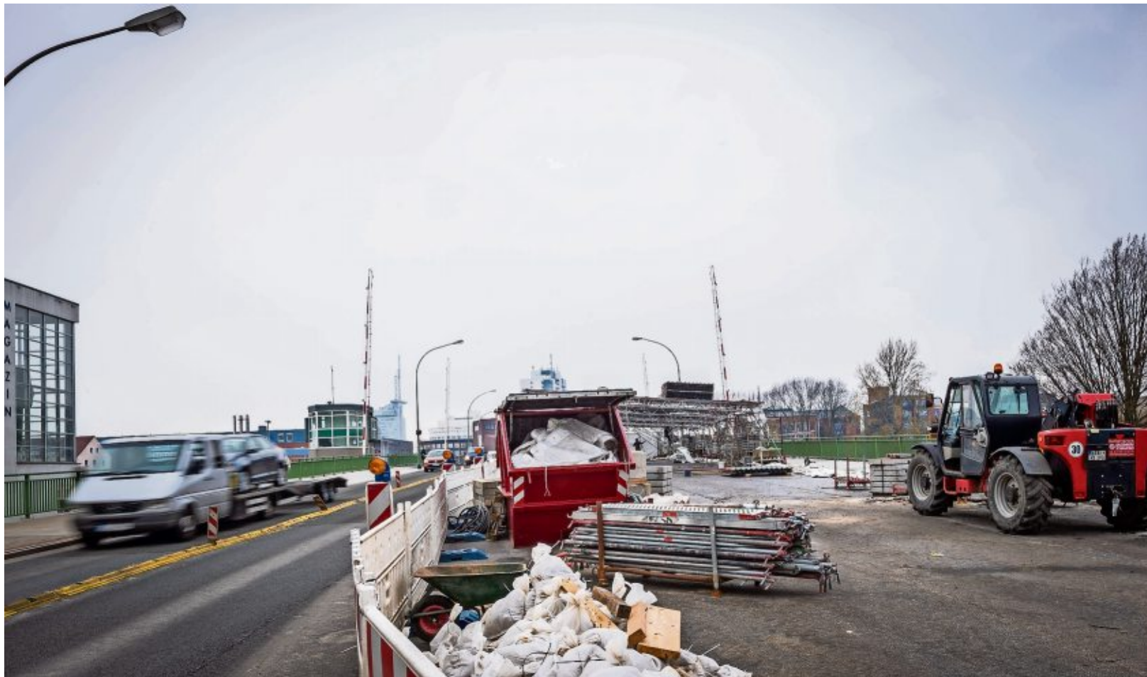
Kein Scherz: Ab 1. April sollen wieder alle Fahrspuren auf der Kennedybrücke zur Verfügung stehen. Zurzeit stehen noch Restarbeiten auf der Klappbrücke an.
